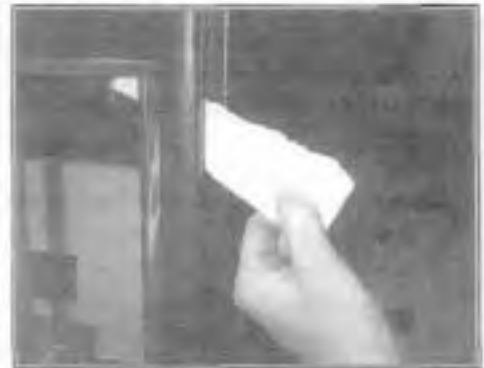
Checking Door Gasket
