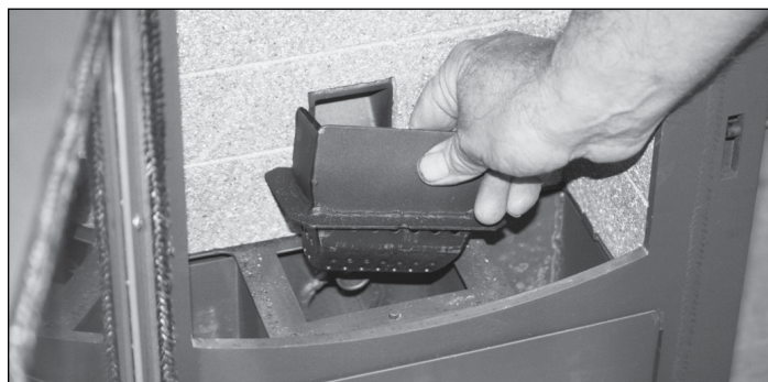
Figure 30 : Nettoyage de la boîte à feu
