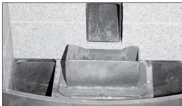
Figure 14 : Nettoyage de la boîte à feu
